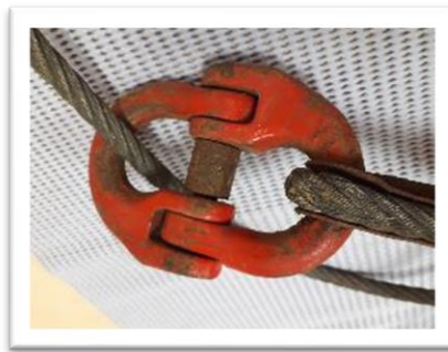
Óxido en conectores
